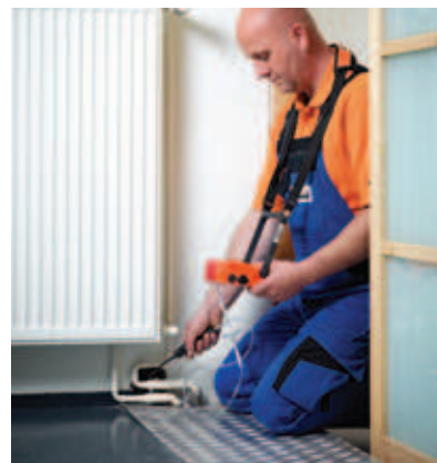
Figura 9. Detecção de fugas em redes domésticas de água e de aquecimento, através dos métodos acústicos e gás traçador.
