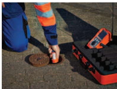
Figura 2. Instalação de pré-localizador de fugas ( logger de ruído).
